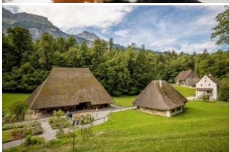
Image 4: remplacement du toit de chaume
