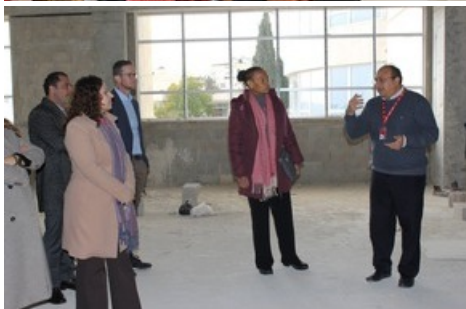
En visite dans la construction du futur centre chirurgical de jour. Photo: KHB.
