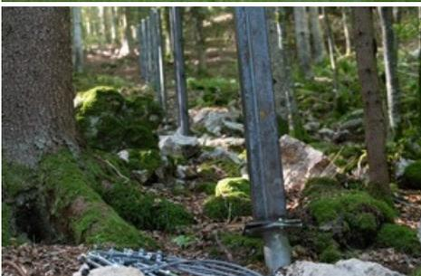
*Pour fixer la clôture, on a recouru à des ancrages de sol de 130 cm de long au lieu de fondations en béton. Les poteaux sont vissés sur ces ancrages. / Texte complémentaire par ots et sur [www.presseportal.ch/fr/nr/100053189](http://www.presseportal.ch/fr/nr/100053189) / L'utilisation de cette image est pour des buts rédactionnels gratuite. Publication sous indication de source: "obs/Debrunner Acifer AG"*
