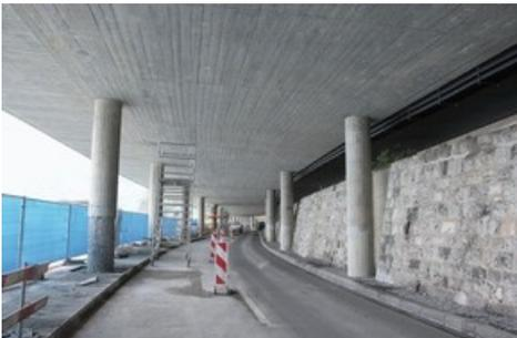
*Localement corrodé par l'eau salée de la chaussée, le béton de la galerie du viaduc autoroutier a dû être assaini. Texte complémentaire par ots et sur [www.presseportal.ch/fr/nr/100053189](http://www.presseportal.ch/fr/nr/100053189) / L'utilisation de cette image est pour des buts rédactionnels gratuite. Publication sous indication de source: "obs/Debrunner Acifer AG/©Debrunner Acifer"*
