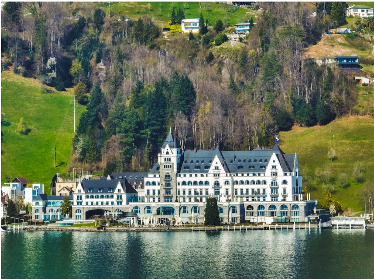
Bild 4: SavSan wird durch eine Kooperation vom Park Hotel Vitznau und der Klinik cereneo am Vierwaldstättersee realisiert.
