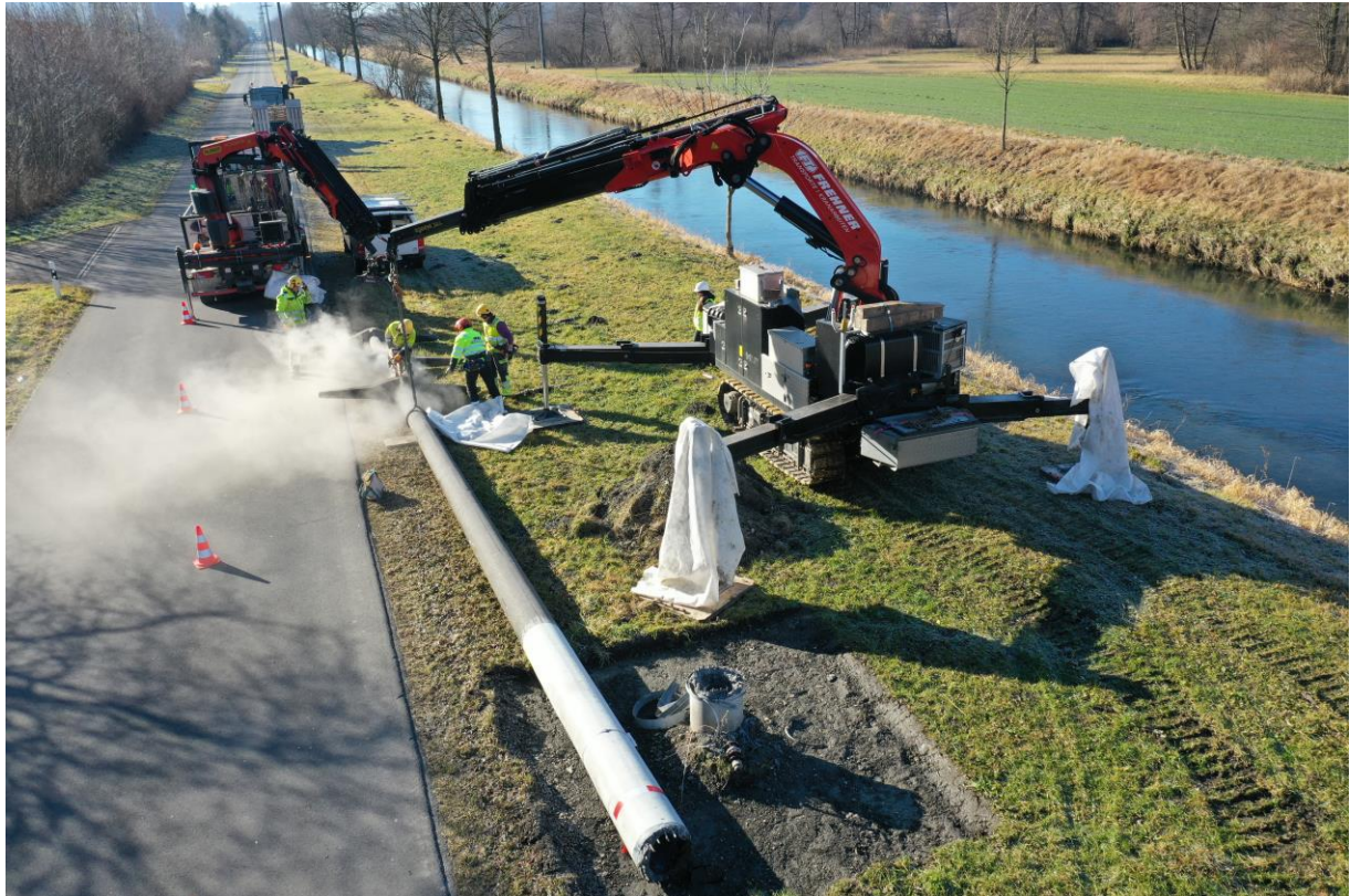
Ein abgelegter Betonmast wird zersägt, um für den Abtransport bereitgemacht zu werden (Foto: SAK)
