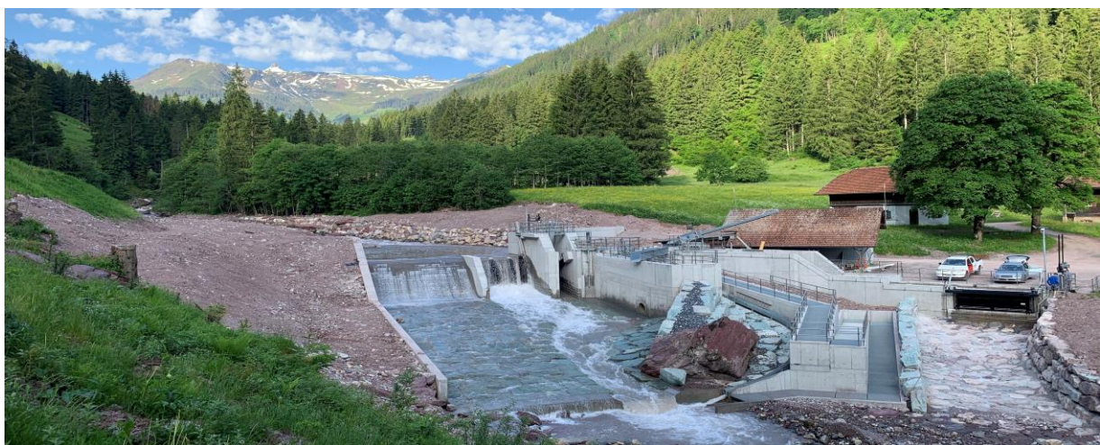
Die Wasserfassung und die Fischtreppe bei Bruggwiti im Schilstal, oberhalb Flums (Bild: SAK).
