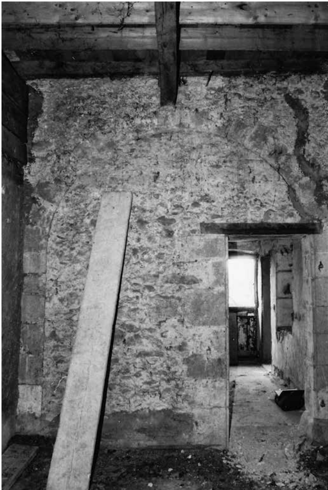
20 Das Trottentor von 1762 wurde im Rahmen der Erweiterung zugemauert, fortan führte eine Tür in die Küche. Foto, 1984 [FLM AltA 104.02]
