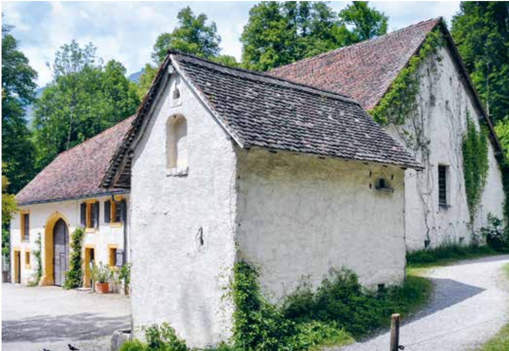
23 Das Taubenhaus mit Ausflüglöchern aus zweitverwendeten Schiessscharten des Schlosses Saconnex d'Arve. Ansicht Südost, Foto FLM, 2018 (FLM digKat).
