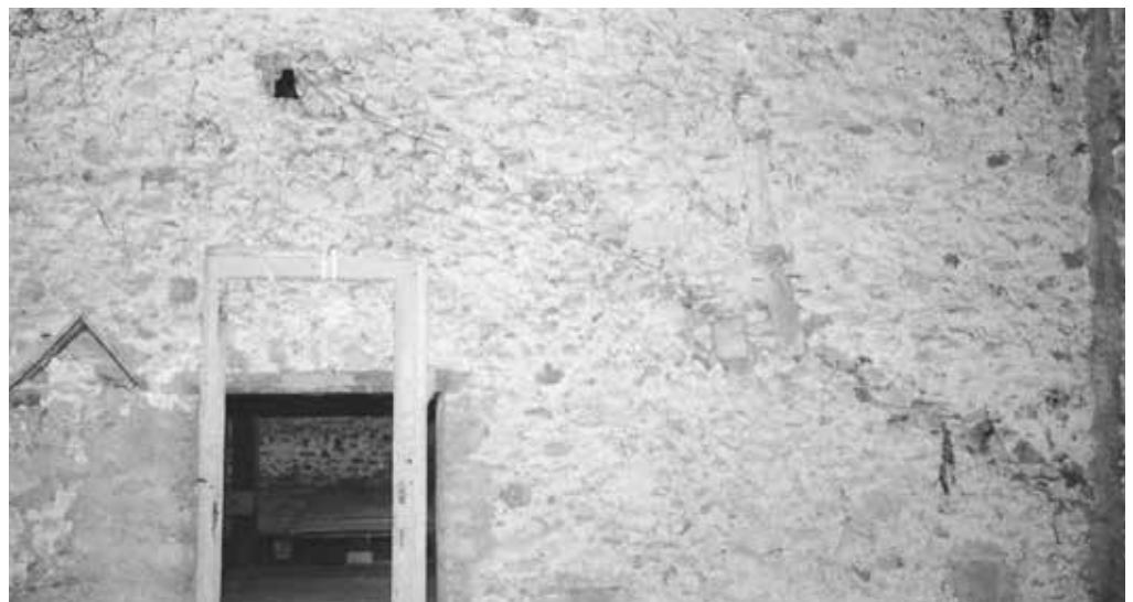
8 Die ursprüngliche Dachkante hatte sich an der Querwand abgezeichnet. Foto. Abbruchdokumentation, 1984 (FLM 104.02).
