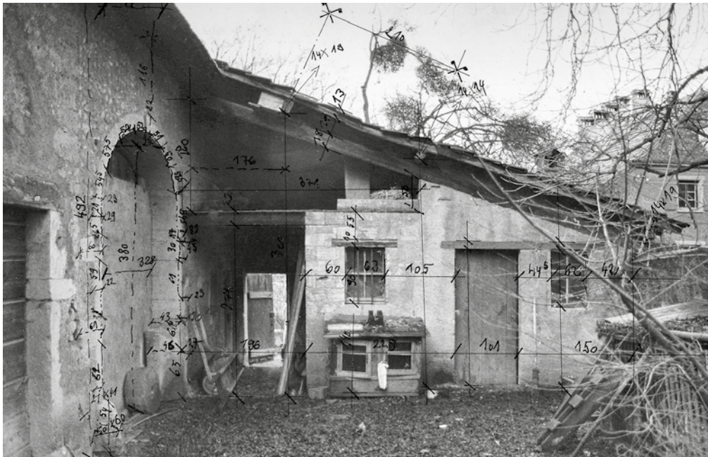
12 Die Hofansicht dokumentiert die Nutzung des hofseitigen Anbaus als Hühnerstall. Fotogrammetrische Bauaufnahme, 1984 (FLM AltA 111).
