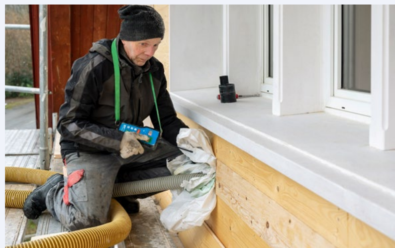
De la cellulose est pulsée derrière la façade en bardeaux d'une maison d'Appenzell protégée au titre de monument historique. Cet assainissement a bénéficié du soutien du Programme Bâtiments.
