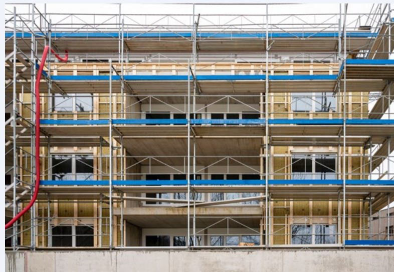
La résidence pour personnes âgées est isolée selon le label Minergie.
