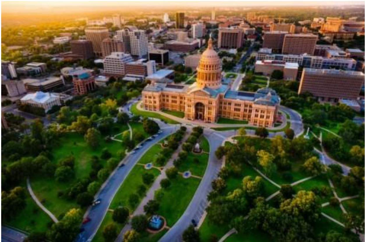
Vue aérienne du bâtiment du Capitole à Austin, la capitale du Texas
