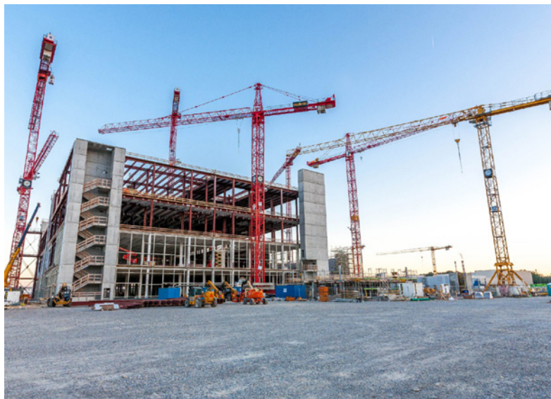
Biogen Baustelle im September 2016
