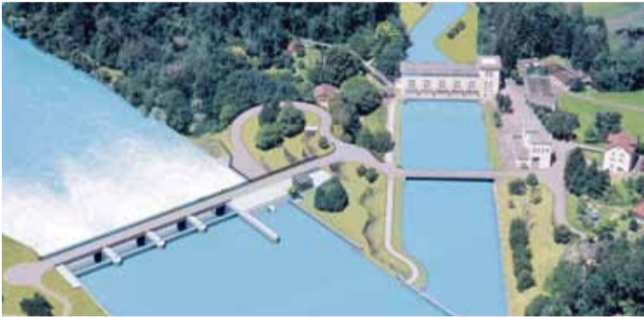
Rénovation de la centrale hydraulique d'Hagneck par FMB
