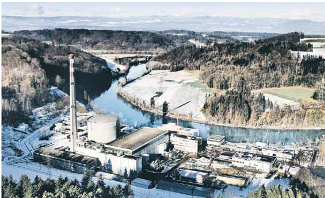
Das Kernkraftwerk Mühleberg produziert seit 1972 zuverlässig und klimafreundlich Strom
