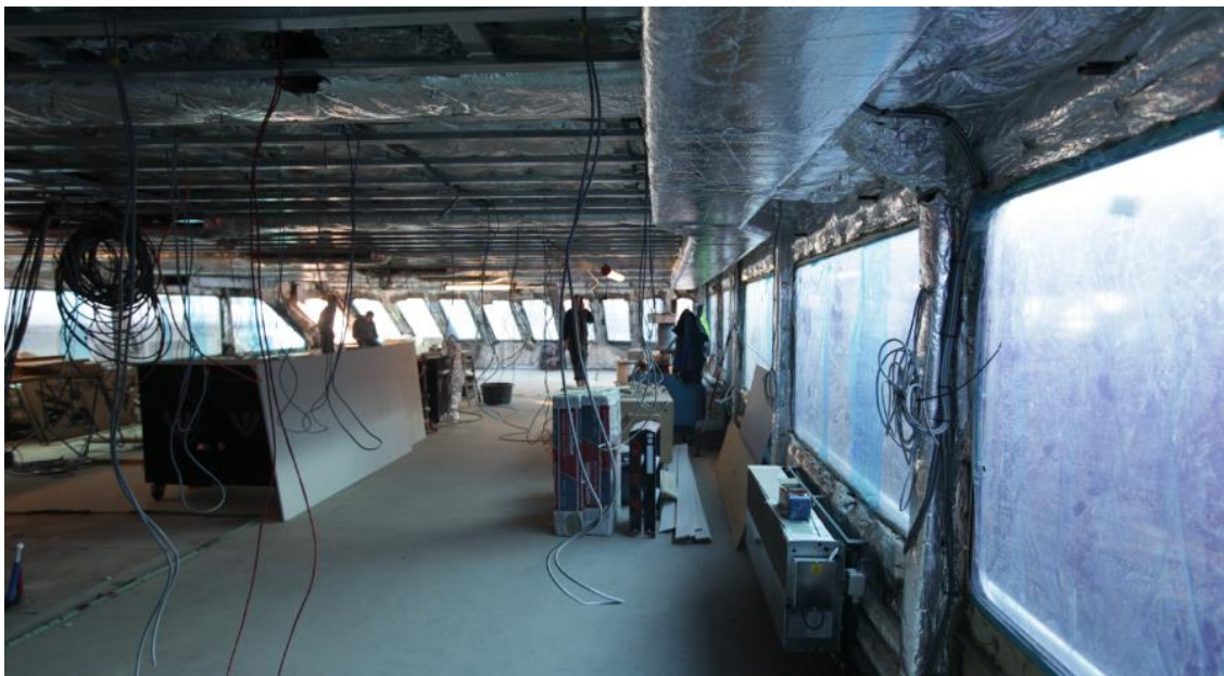
Hier entsteht die Lounge mit der Panoramabar
