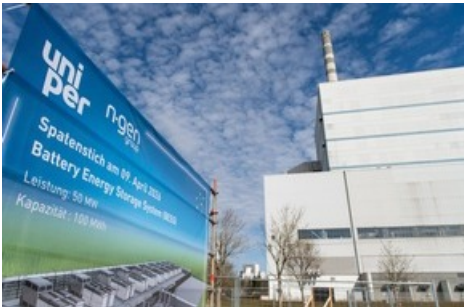
Am Uniper-Gelände in Wilhelmshaven entsteht eine 50 MW Batteriespeicheranlage
