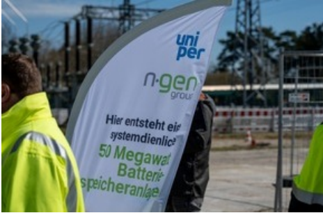
Detail - Spatenstich 50 MW Batteriespeicheranlage in Wilhelmshaven
