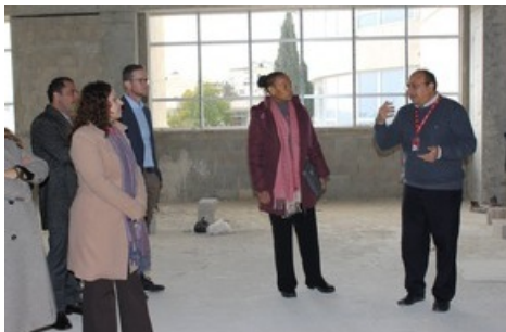
Führung durch den Rohbau. Foto: KHB
