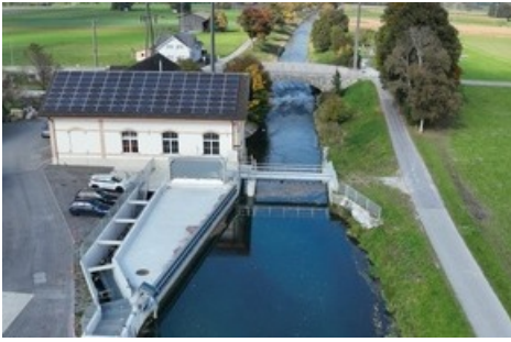
Wasserkraftwerk Montlingen am Rheintaler Binnenkanal mit neuem Fischpass und Horizontalrechen (Bild: SAK)
