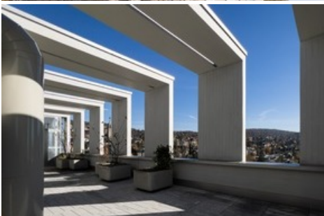
Die Dachterrasse auf dem Careum Hochhaus an der Plattenstrasse 10 in Zürich. Bild: Careum
