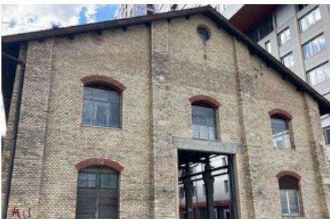
Historische Elsässer Markthalle: Das Fondue Chalet wird in der Markthalle aufgebaut.
