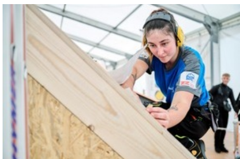
Dachdecker/in EFZ - Couvreur CFC / Couvreuse CFC - Copritetto AFC - SwissSkills 2022 - 08.09.2022, Bern. © Manu Friederich / SwissSkills
