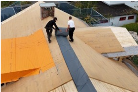
Verlegung Ampatop® Protecta 3D-Vorkonfektion 1
