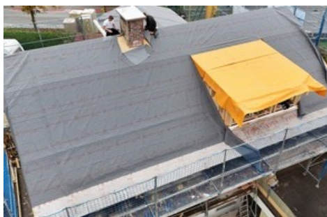
Verlegung Ampatop® Protecta 3D-Vorkonfektion 4
