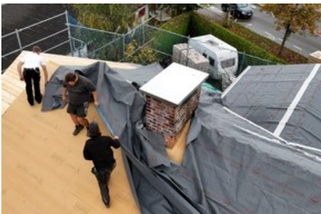
Verlegung Ampatop® Protecta 3D-Vorkonfektion 3
