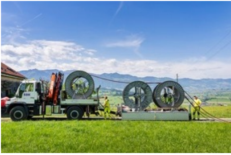
Vorbereitung für den Kabelzug im Gebiet Uznach und Niederurnen (Foto: SAK).
