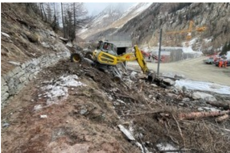
Errichtung des Schutzdamms
