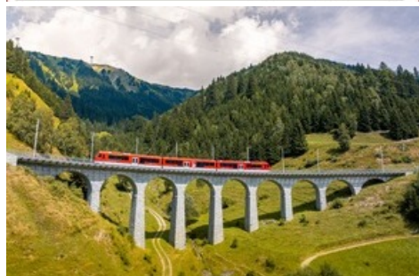
ORION-Triebzug der MGBahn auf dem Viadukt Bugnei-Sedrun in der Surselva (GR)
