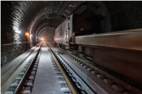
Betonfahrbahn im Lötschberg-Scheiteltunnel (Bild: BLS).
