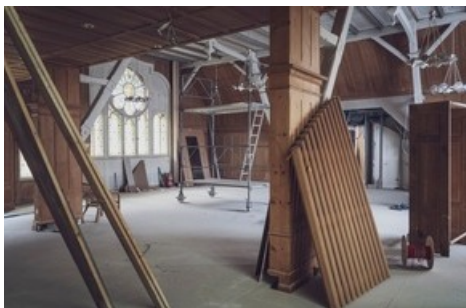
Dient künftig als aussergewöhnliche Event-Location: «The Chapel» im obersten Stock des Hotel «Joseph's House».
