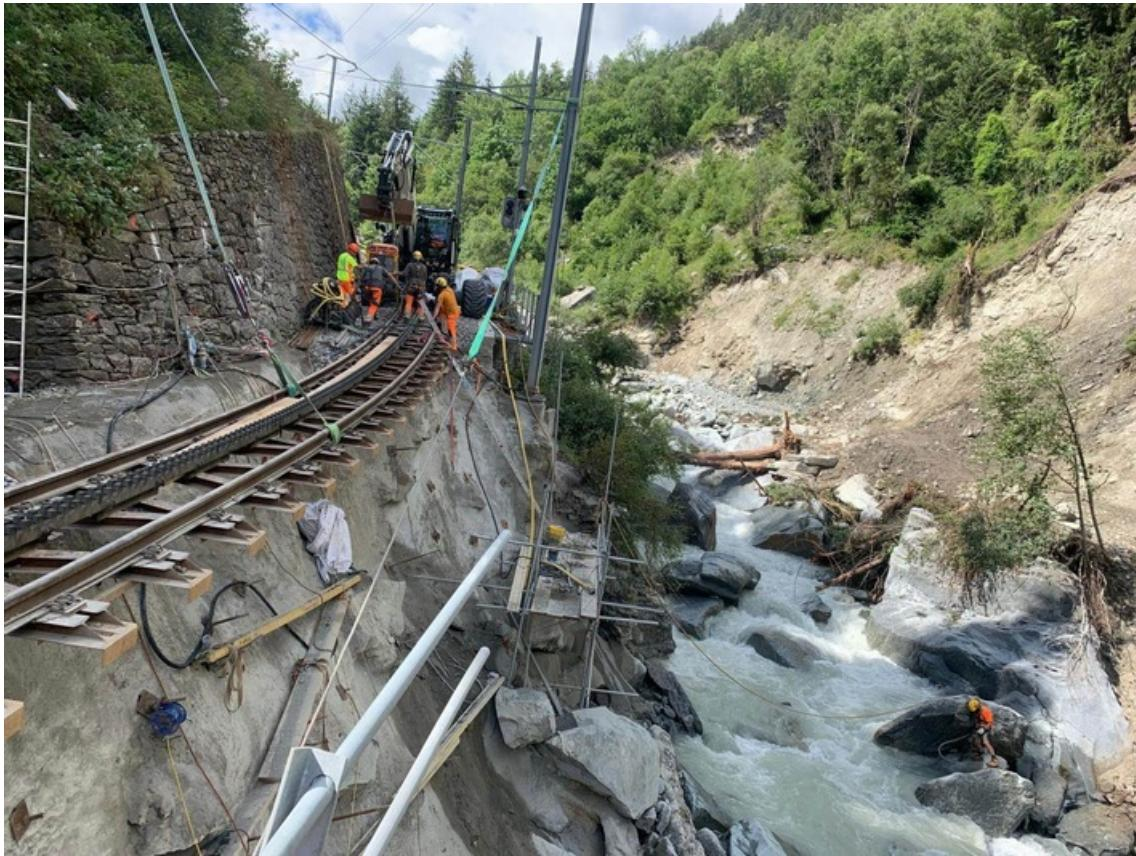
Die Instandsetzungsarbeiten, die durch die Hochwasser Ende Juni beschädigten Bahngleise im Mattertal, sind aufgrund des aktuellen vielen Schmelzwassers in der Vispa sehr anspruchsvoll. Zwischen Visp und Täsch verkehren immer noch Bahnersatzbusse. Zermatt ist sicher mit öffentlichen Verkehrsmittel erreichbar. Frühestens ab 26. August 2024 kann mit einem durchgehenden Bahnbetrieb der Matterhorn Gotthard Bahn zwischen Visp und Zermatt gerechnet werden.
