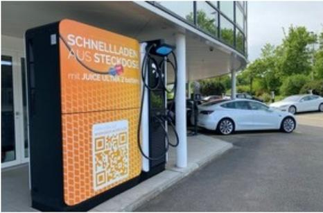
*Der JUICE ULTRA 2 battery ermöglicht eine hohe Ladeleistung trotz niedriger Netzanschlussleistung. Die Belastung des Netzes wird auf ein Minimum reduziert. / Juice Technology AG*
