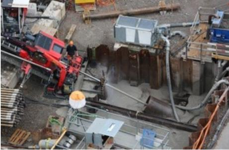
Um die Leitungen zu verlegen, waren zwei Spülbohrungen auf einer Länge von je 600 Metern in etwa 29 Metern Tiefe nötig. / Weiterer Text über ots und [www.presseportal.ch/de/nr/100053189](http://www.presseportal.ch/de/nr/100053189) / Die Verwendung dieses Bildes für redaktionelle Zwecke ist unter Beachtung aller mitgeteilten Nutzungsbedingungen zulässig und dann auch honorarfrei. Veröffentlichung ausschließlich mit Bildrechte-Hinweis.
