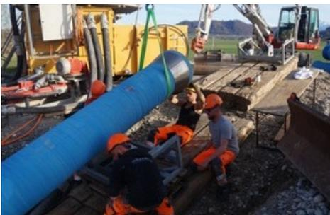
*Für die zwei neuen Trinkwasserleitungen stellte Debrunner Acifer 1200 Meter duktile Gussrohre bereit. / Weiterer Text über ots und [www.presseportal.ch/de/nr/100053189](http://www.presseportal.ch/de/nr/100053189) / Die Verwendung dieses Bildes für redaktionelle Zwecke ist unter Beachtung aller mitgeteilten Nutzungsbedingungen zulässig und dann auch honorarfrei. Veröffentlichung ausschließlich mit Bildrechte-Hinweis.*
