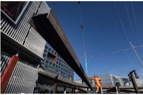
Die 270 t Stahlträger von Debrunner Acifer mit Längen von 16 bis 22 m wurden für 1875 m<sup>2</sup> Rühlwände eingesetzt. Der schwerste Träger wog 5.3 t. / Weiterer Text über ots und [www.presseportal.ch/de/nr/100053189](http://www.presseportal.ch/de/nr/100053189) / Die Verwendung dieses Bildes für redaktionelle Zwecke ist unter Beachtung aller mitgeteilten Nutzungsbedingungen zulässig und dann auch honorarfrei. Veröffentlichung ausschließlich mit Bildrechte-Hinweis.
