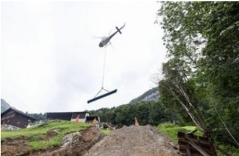
Ein Helikopter transportiert die Trinkwasserrohre zur Baustelle oberhalb der Steilstufe und in die Steilstufe. / Weiterer Text über ots und [www.presseportal.ch/de/nr/100053189](http://www.presseportal.ch/de/nr/100053189) / Die Verwendung dieses Bildes ist für redaktionelle Zwecke honorarfrei. Veröffentlichung bitte unter Quellenangabe: "obs/Debrunner Acifer AG/Raffael Soppelsa Fotografie"
