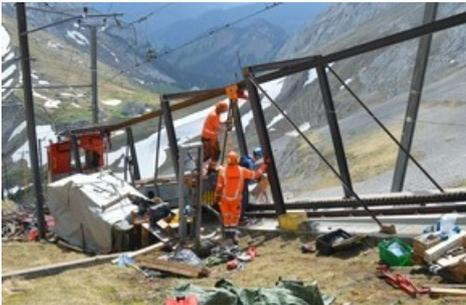
*Millimeterarbeit bei der Montage des fünften und letzten Gleiswenders bei der Bergstation Pilatus Kulm Mitte Mai 2022 (Foto: Severin Wallimann)*
