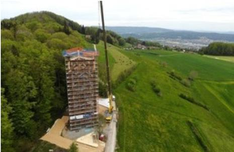
*Für die Stabilität des imposanten Holz-Stahl-Baus sorgen unter anderem Stabdübel, Holzverbinder und Vollgewindeschrauben von Debrunner Acifer. / Weiterer Text über ots und [www.presseportal.ch/de/nr/100053189](http://www.presseportal.ch/de/nr/100053189) / Die Verwendung dieses Bildes ist für redaktionelle Zwecke honorarfrei. Veröffentlichung bitte unter Quellenangabe: "obs/Debrunner Acifer AG/Picasa"*
