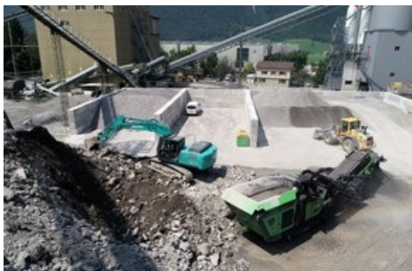
In Oberdorf bereitet die ARGE EvoREC Beton- und Mischabbruch zu hochwertigen Sekundärrohstoffen auf.
