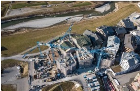
Andermatt Reuss mit sechs Mehrfamilienhäusern im Bau - Valentin Luthiger © Andermatt Swiss Alps
