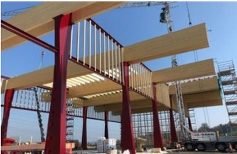
*Die mächtige Holz-Stahl-Konstruktion der Entsorgungshalle: 24 konisch konstruierte, 13 m hohe Stahlstützen sowie 24 Holzbinder von je 2 m Höhe und 36 m Länge. / Weiterer Text über ots und [www.presseportal.ch/de/nr/100053189](http://www.presseportal.ch/de/nr/100053189) / Die Verwendung dieses Bildes ist für redaktionelle Zwecke honorarfrei. Veröffentlichung bitte unter Quellenangabe: "obs/Debrunner Acifer AG/Copyright: Debrunner Acifer AG"*
