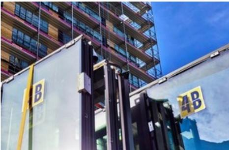
4B lieferte für den 31 Meter hohen Neubau auf dem SisCampus die über 1'100 m<sup>2</sup> grosse Fassade mit dimmbarem Glas. Verbaut wurden bis zu 1.5 Tonnen schwere Pfosten-Riegel-Elemente. Der hohe Vorfertigungsgrad garantierte höchste Effizienz bei Produktion und Montage.
