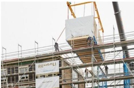
Mit einem Kran wurden die einzelnen Module millimetergenau im Stahlgerüst eingesetzt. Weiterer Text über [ots](http://ots) und [www.presseportal.ch/de/nr/100053189](http://www.presseportal.ch/de/nr/100053189) / Die Verwendung dieses Bildes ist für redaktionelle Zwecke honorarfrei. Veröffentlichung bitte unter Quellenangabe: "obs/Debrunner Acifer AG/Quelle: Renggli AG"
