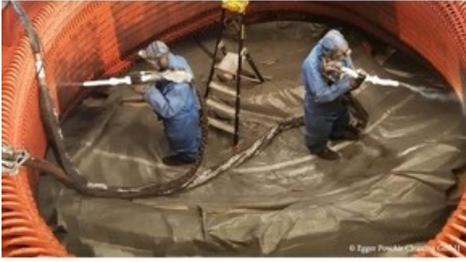
Egger PowAir Cleaning GmbH das Spezialunternehmen zur Reinigung von Industrie- und Produktionsanlagen, mobil in ganz Europa, wurde für die Reinigung eines Wasserkraftwerkes (Wasserkraftgenerator, Reinigung von Rotor und Stator) der französischen Elektrizitätsgesellschaft EDF an einem Standort in Frankreich zum wiederholten Mal mit der Reinigung beauftragt. Egger PowAir Cleaning GmbH reinigt mit Kalter Trocken Druck Luft und sonst nichts (KDL-Verfahren).
