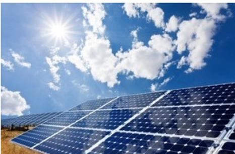
*Dank der Antireflex-Beschichtung von 3M kann die Lichtdurchlässigkeit bislang unbehalteter Glasoberflächen von Photovoltaik-Anlagen um bis zu 2,5 Prozent erhöht und dadurch die Stromerzeugung nachhaltig gesteigert werden. Bild: Getty / FernandoAH / 3M. Nutzung des Bildmaterials ausschließlich in einem dem Text entsprechenden Bezug mit Nennung der vollständigen Quellenangaben.*
