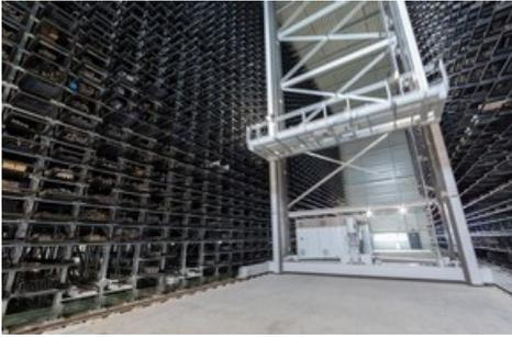
*Das neue Hochregallager der Debrunner Acifer AG in Birsfelden bietet mit seinen 40 Metern Länge, 21 Metern Höhe und 25 Metern Breite Platz für 3 000 Kassetten und 9'000 Tonnen Stahl. Weiterer Text über ots und [www.presseportal.ch/de/nr/100053189](http://www.presseportal.ch/de/nr/100053189) / Die Verwendung dieses Bildes ist für redaktionelle Zwecke honorarfrei. Veröffentlichung bitte unter Quellenangabe: "obs/Debrunner Acifer AG/zvg"*
