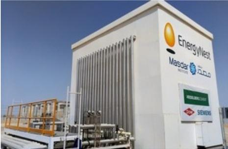
*Das Masdar Institut in Abu Dhabi und EnergyNest haben 2013 ein gemeinsames Forschungsprojekt initiiert, das den Bau und Test eines Energie-Pilotspeichers mit 2 x 500 kWh thermisch umfasst. Die Pilotanlage ist mittlerweile voll funktionsfähig und wurde von der DNV GL in Bezug auf die Aspekte Betriebstemperatur, Energiespeicherkapazität und Energieeffizienz validiert.*
