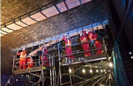
Insgesamt wurden 1'300 Meter kohlenstofffaserverstärkte Lamellen angebracht, die nur gerade 4.7 Millimeter dick sind. Weiterer Text ueber ots und auf <http://www.presseportal.ch>. Die Verwendung dieses Bildes ist fuer redaktionelle Zwecke honorarfrei. Veroeffentlichung unter Quellenangabe: "OTS.Bild/Sika AG".
