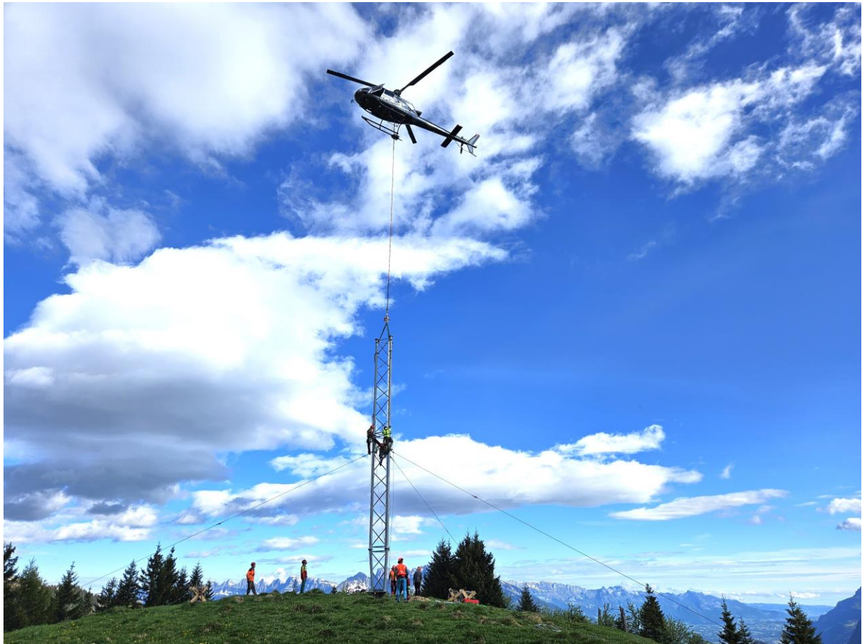
Installation des 80 Meter hohen Messmasts auf dem Grot – St. Margrethenberg (Bild: SAK).
