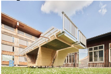
Image 1: Modèle de travail inauguré d'un pont en bois pour charges lourdes à Bienne
