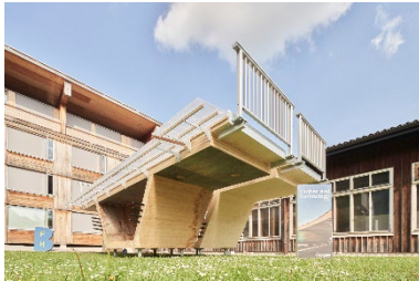
Bild 1: Eingeweichtes Arbeitsmodell einer Schwerlastbrücke aus Holz in Biel
