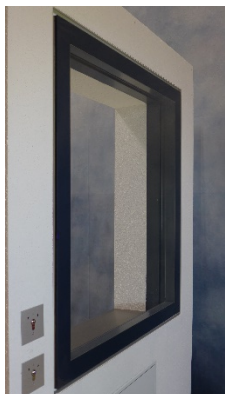
Bild 7: Typ A - Flächenbündiges, nach innen öffnendes Dreh-Fenster, Holzforschung Austria
