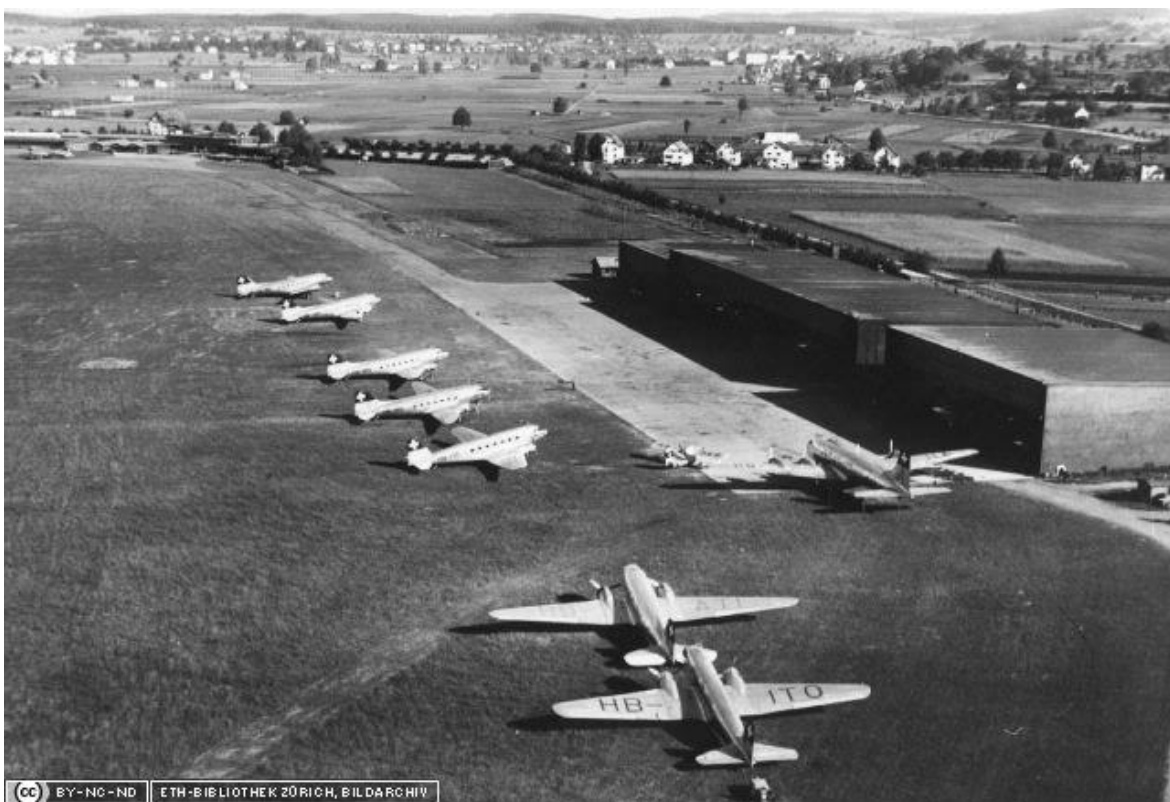
Flugplatz Dübendorf mit den historischen zivilaviatischen Hangars sowie einer Gruppe DC-3 und der DC-4 HB-ILA Swissair sowie einer DC-2 HB-ITO, Luftbild aus Osten, im Hintergrund Wangen
